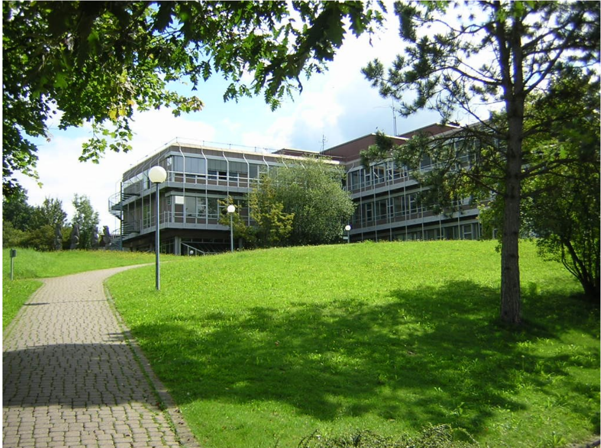
H-Gebäude, a főépület
